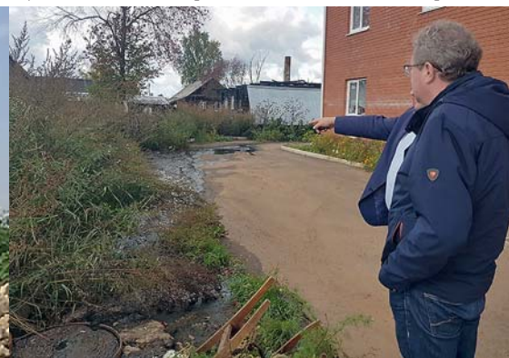
Засорившийся канализационный сток многоквартирного дома спецжилфонда для лиц из числа детей-сирот в с. Карагай
