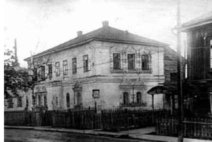
Дом воеводы – штаб госпиталя № 2570
