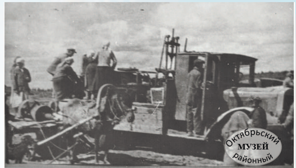
Разгрузка оборудования ЛенЗОСа на ст. Чад. 1941 г.
