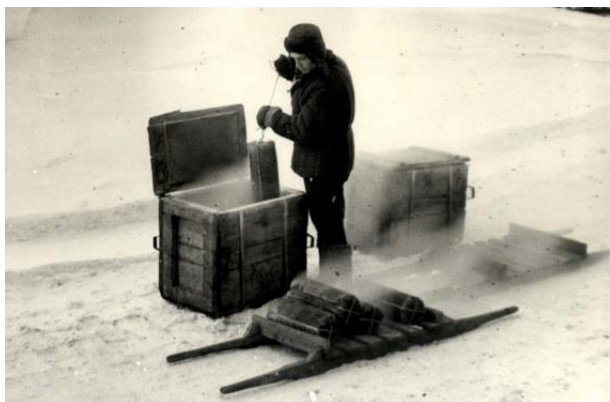
Рис. 8. Выемка насыщенных кислородом оксипатронов. 1944 г.
