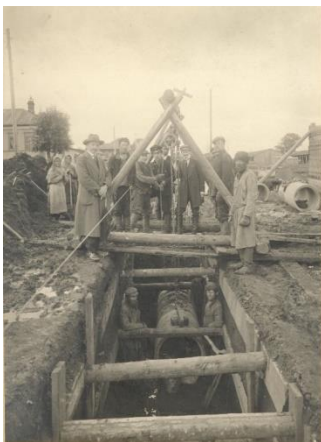
Рис. 2. Строительство канализационной сети в Перми. Слева в шляпе – А.Е. Ширяев. 1915–1916 гг.
