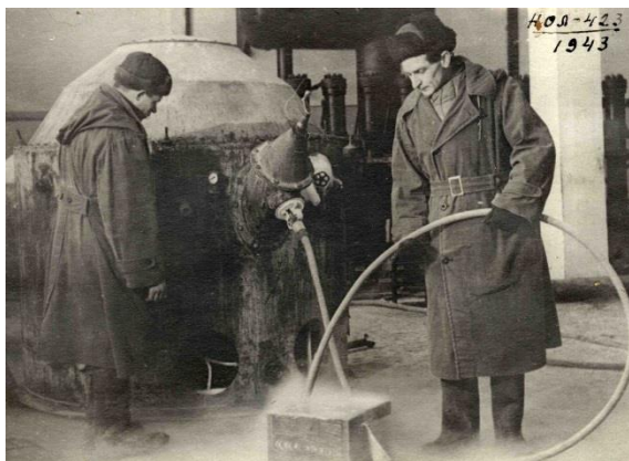
Рис. 5. Насыщение кислородом оксипатронов (справа Ю.Н. Зинюк). 1943 г.
