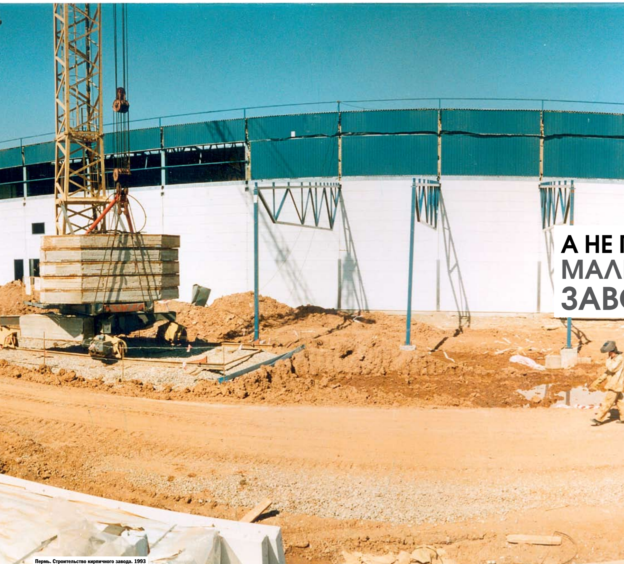
Пермь. Строительство кирпичного завода. 1993
