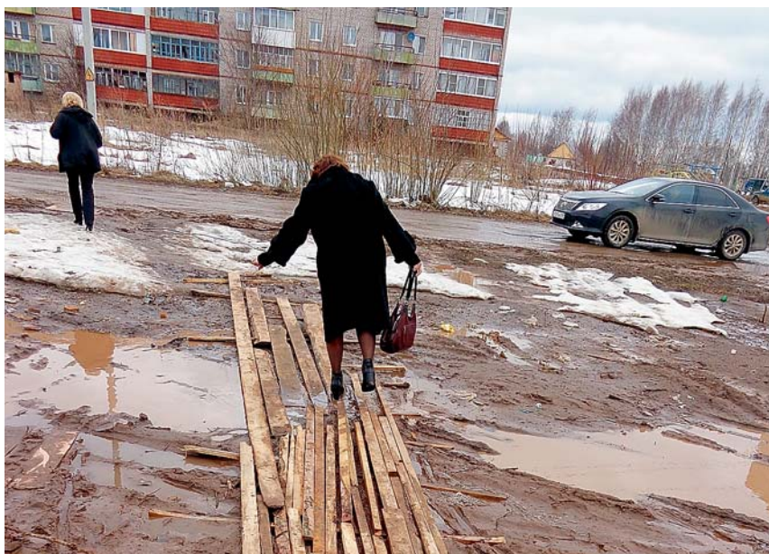
Благоустройство у домов, построенных в рамках программы «Переселение из ветхого и аварийного жилья» Оханский район
